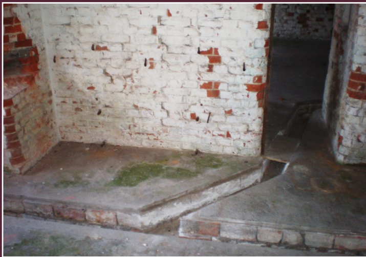
ślady po instalacjach wodnych w izbach żołnierskich
